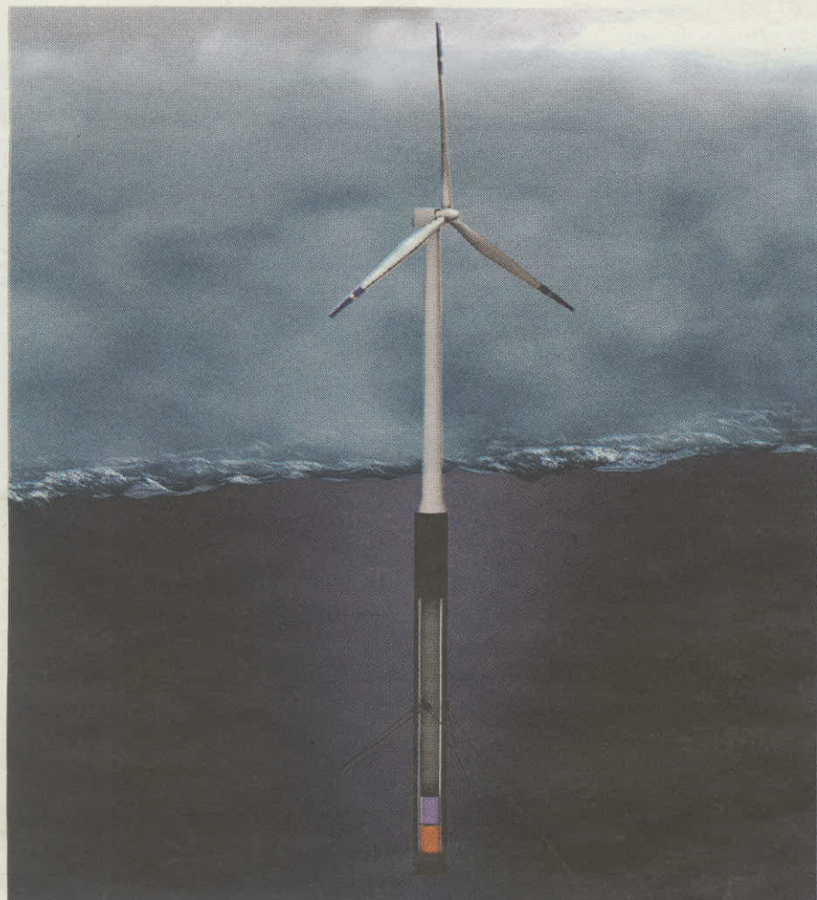
De Hywind bij Stavanger is de eerste drijvende windmolen die ook onder barre omstandigheden op zee daadwerkelijk produceert.
